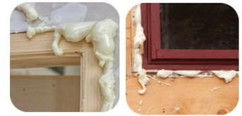
**APLICACIÓN:** Producto desarrollado para llenar espacios vacíos, sellado de espacios en la instalación de sistemas de aire acondicionado y ventilación, sellado de huecos y grietas de gran dimensión en y alrededor de tubos, conductos, respiraderos, tomacorrientes y cimientos. Rellenado de paredes de mampostería, espacios en entresijos y relleno de marcos de puertas y ventanas. Útil en el sellado de perforaciones de ductos de ventilación y tuberías sanitarias.
