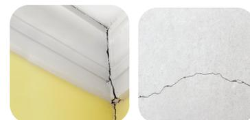
**APLICACIÓN:** Rellenado de grietas y fisuras con moderado movimiento en exteriores e interiores sobre concreto, yeso o mampostería.
